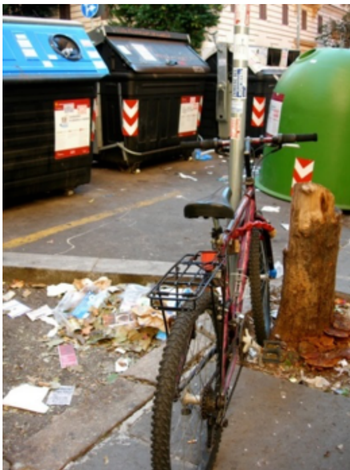
Foto n. 5 CASSONETTI DELLA SPAZZATURA IN STATO DI DEGRADO ALBERATURE CROLLATE, L'ASSENZA DI ARREDO URBANO: CESTINI DELLA SPAZZATURA, PARCHEGGI PERLE BICICLETTE ETC.
